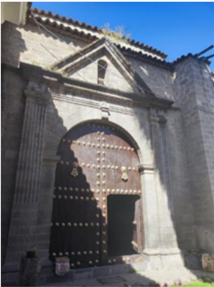
**Nota.** La imagen muestra el estado de abandono de la puerta alterna que colinda con la Municipalidad Provincial de Huamanga; la maleza ha crecido y el techo se ha deteriorado por falta de mantenimiento. Fotografía tomada por los autores 2024.
